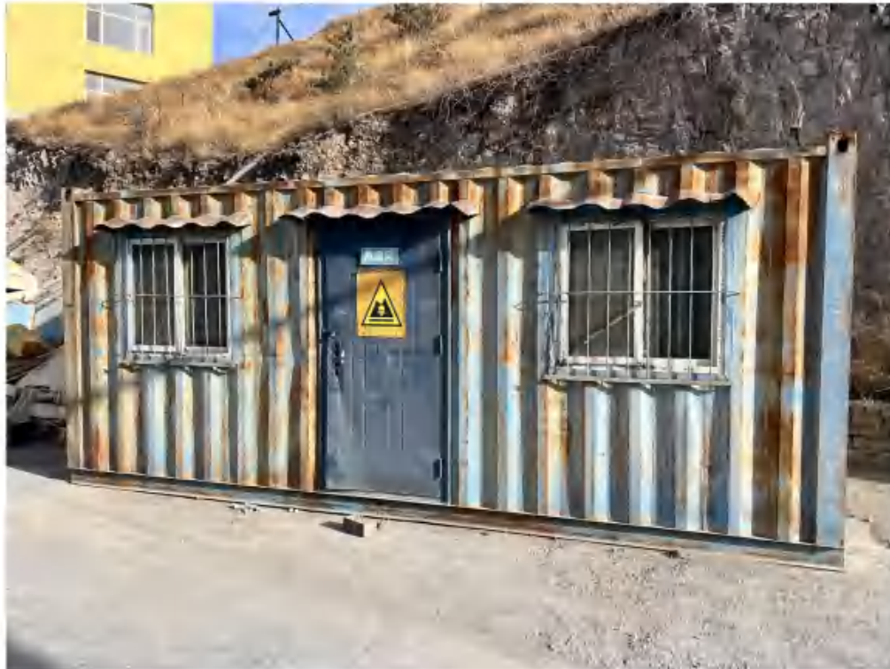
图 3-4 项目厂区危废间现场照片
