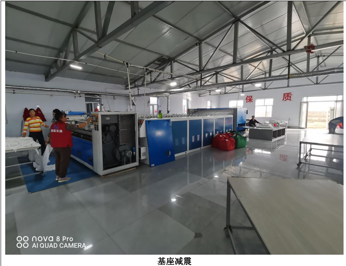
图 3.2-4 噪声防治设施现场照片
